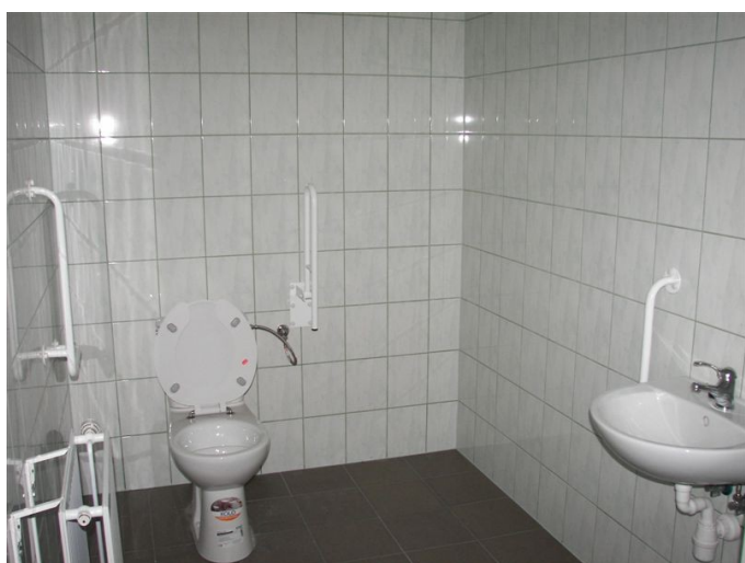
Łazienka dla niepełnosprawnych w nowym budynku GZOZ w Bachowicach przy ul. Górki
