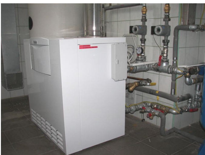
Kotłownia w nowym budynku GZOZ Ryczowie przy ul Parkowej
