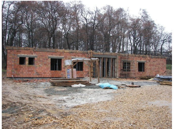
Ściany parteru nowego budynku GZOZ w Ryczowie (listopad 2007r.)
