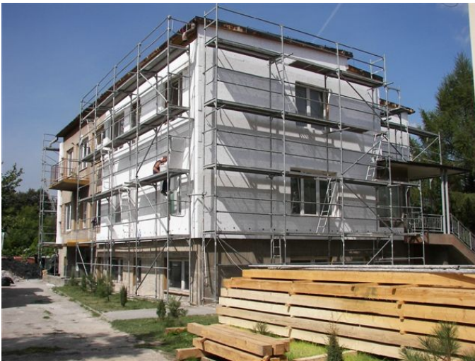
Budynek GZOZ w Spytkowicach podczas prac remontowych (wrzesień 2007r)
