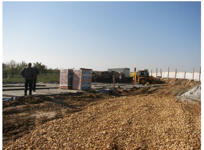
Fundamenty nowego budynku GZOZ w Bachowicach ( wrzesień 2007r.)
