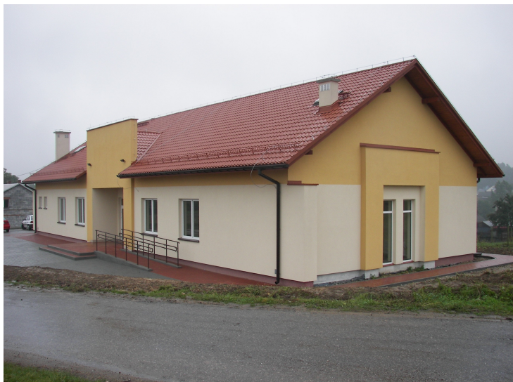
Budynek Gminnego Zakładu Opieki Zdrowotnej w Bachowicach przy ul. Górki
