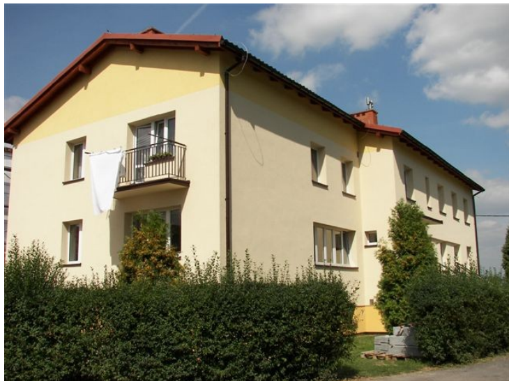
Budynek Gminnego Zakładu Opieki Zdrowotnej Zdrowotnej w Spytkowicach przy ul. Szkolnej 1
