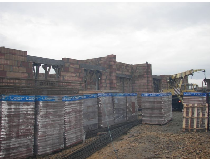
Ściany parteru nowego budynku GZOZ w Bachowicach (listopad 2007r.)
